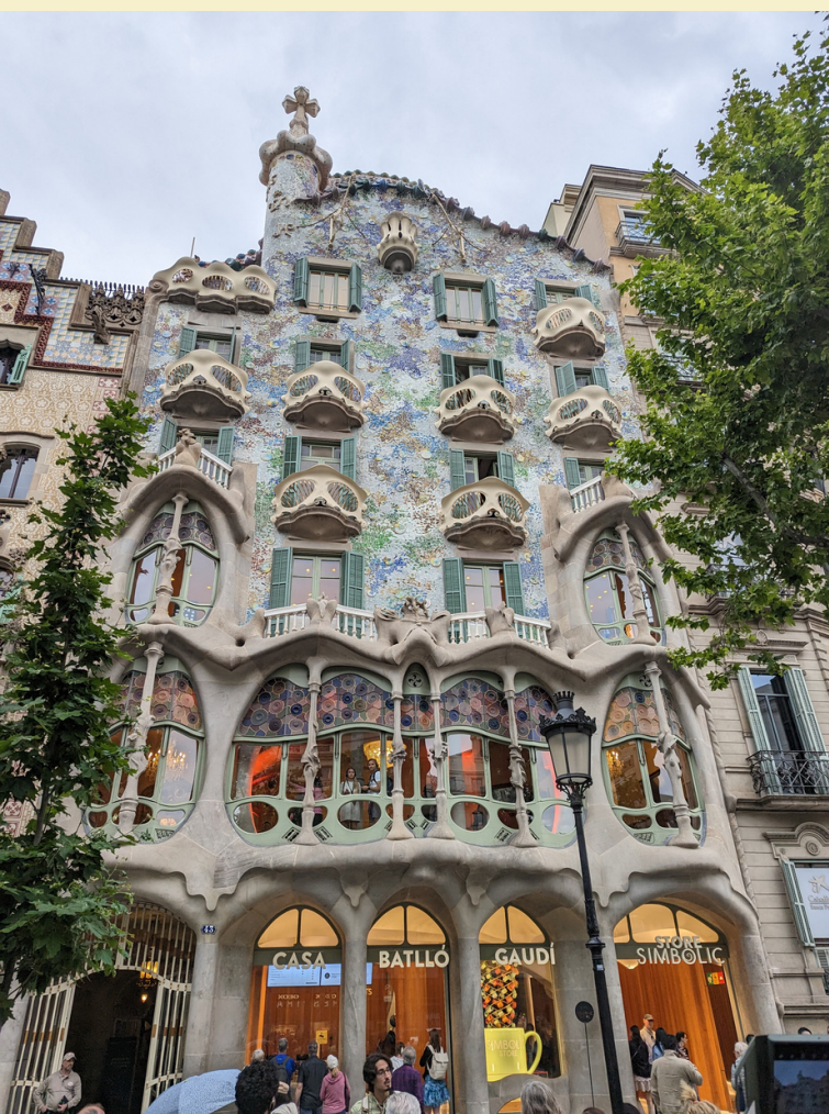
西班牙巴塞隆納 Casa Batlló外觀
